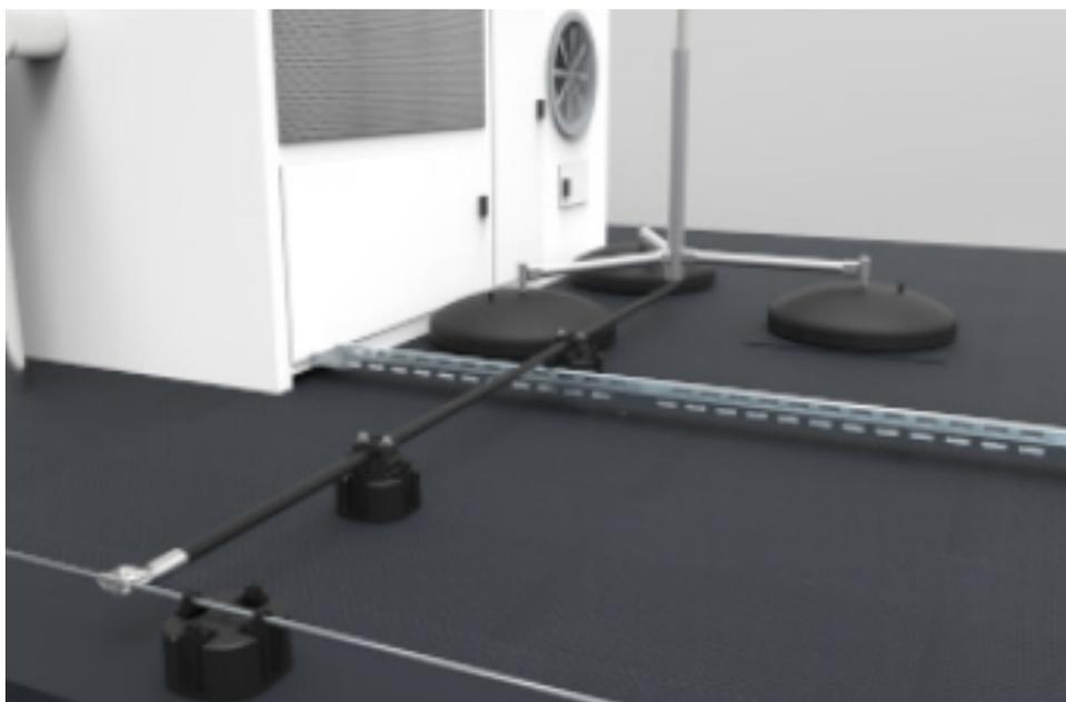
Изолированная молниезащита применяется в тех случаях, когда требуется соблюдение безопасного расстояния (разделительного интервала) от молниеприемников и токоотводов до защищаемого оборудования согласно требованиям международных стандартов по молниезащите (МЭК 62305-3). Чаще всего, данная система выполняется для сооружений со значительным количеством технологического оборудования на кровле, для которого протекание тока молнии по молниеприемнику может представлять опасность
