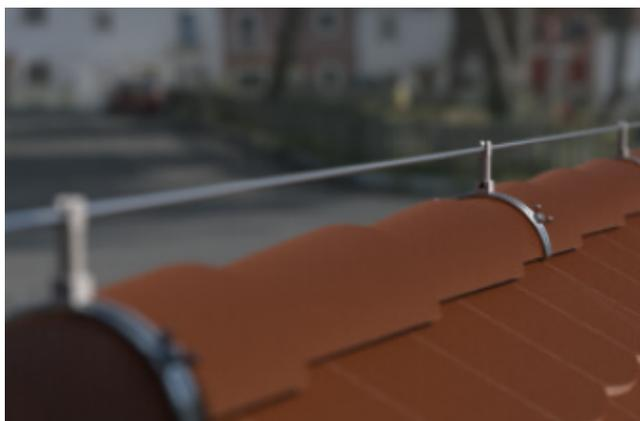
Классическая система внешней молниезащиты и заземления предназначена для построения молниезащиты зданий, токоотводов, контуров заземления и уравнивания потенциалов. Применяемые проводники имеют горячеоцинкованное покрытие, стойкое к коррозии и гарантирующее длительный срок службы (порядка 30 лет). Широкий ассортимент соединителей и держателей делает монтаж системы быстрым и позволяет без затруднений прикрепить проводники к практически любым поверхностям.
